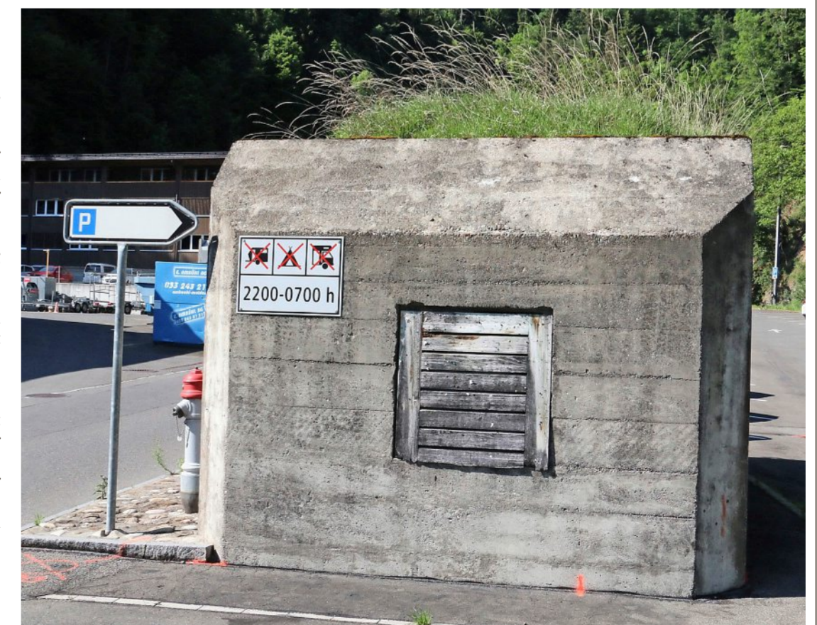
Die Tage dieses Betonbunkers in Gunten sind gezählt. Hier entsteht eine neue Abfallsammelstelle. Sie befindet sich zurzeit in unmittelbarer Nachbarschaft (links). Foto: Andreas Tschopp
