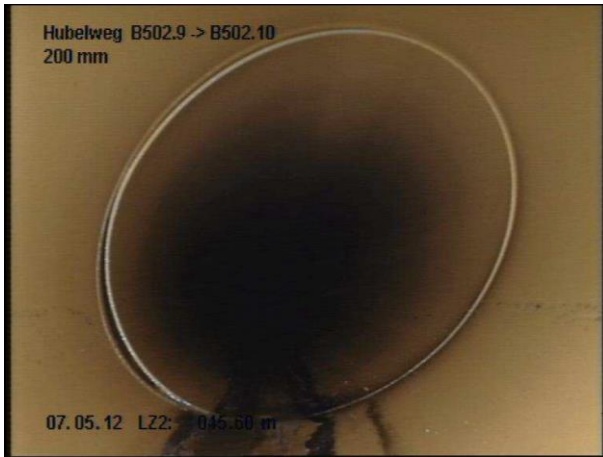
Deformierte Abwasserleitung
