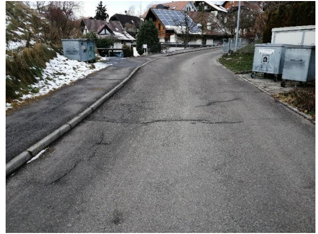
Allgemeinzustand unterer Strassenabschnitt
