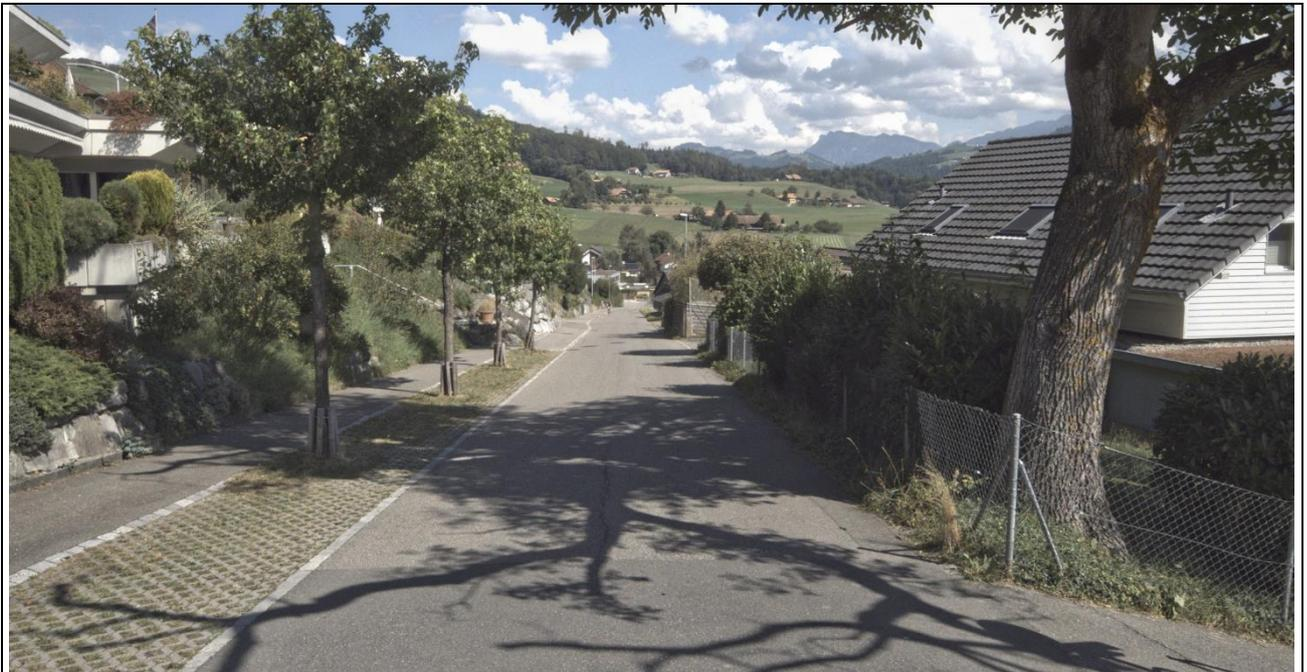
Abbildung 7; Beispiel Strassenquerschnitt mit 4.50 m Fahrbahnbreite
