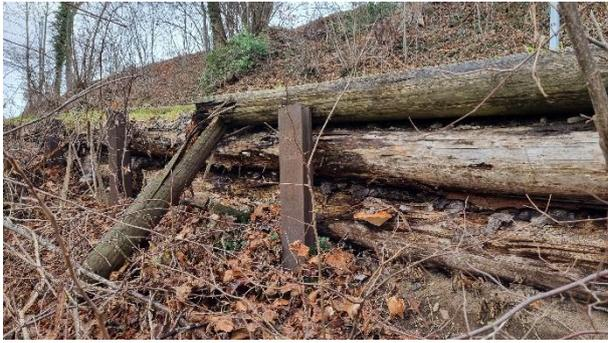
Abbildung 4: Zustand talseitige Hangsicherung
