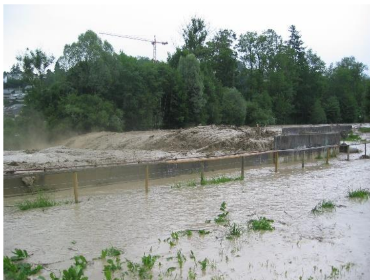
Überflutung der Müllerschwelle beim Hochwasser vom 4. Juli 2012
