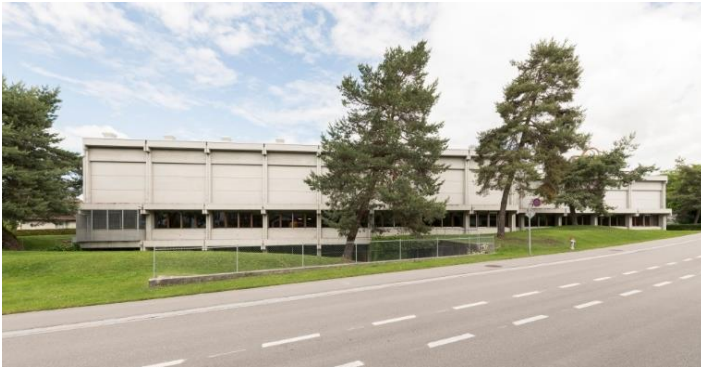
Halle 1 (Erdgeschoss, Grossraumturnhalle)
