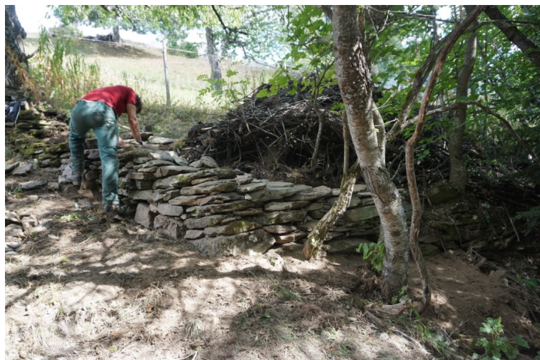
Trockenmauer erhält vom Förster noch den letzten Schliff. (Bild M. Steiner)
