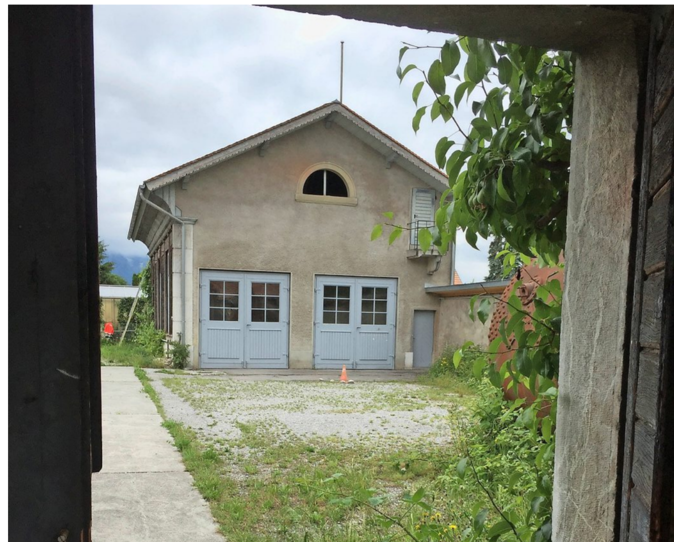
Die Orangerie auf dem Areal der Schadaugärtnerei: Gibt es hier bald eine Gastronutzung? Foto: Michael Gurtner
