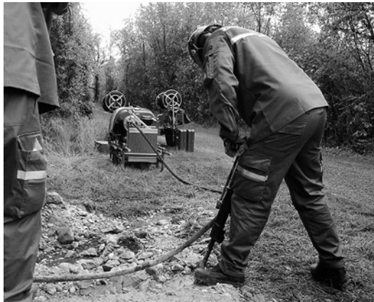
Abtragen der Bodenplatte mit schwerem Gerät
