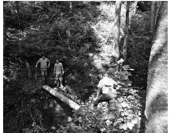
Bau einer Fussgängerbrücke in der Gemeinde Homberg
