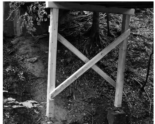
Die Mittelstütze der befahrbaren Brücke konnte ausgewechselt werden
